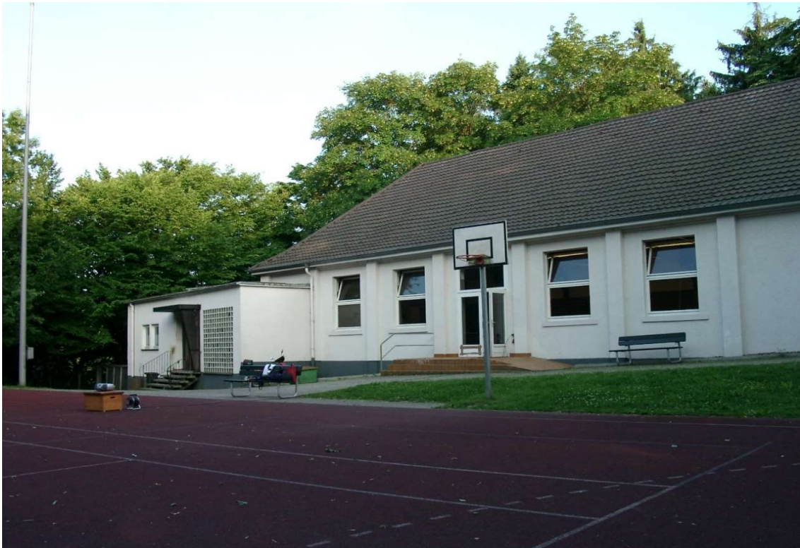
Turnhalle mit 1. Anbau 1966
