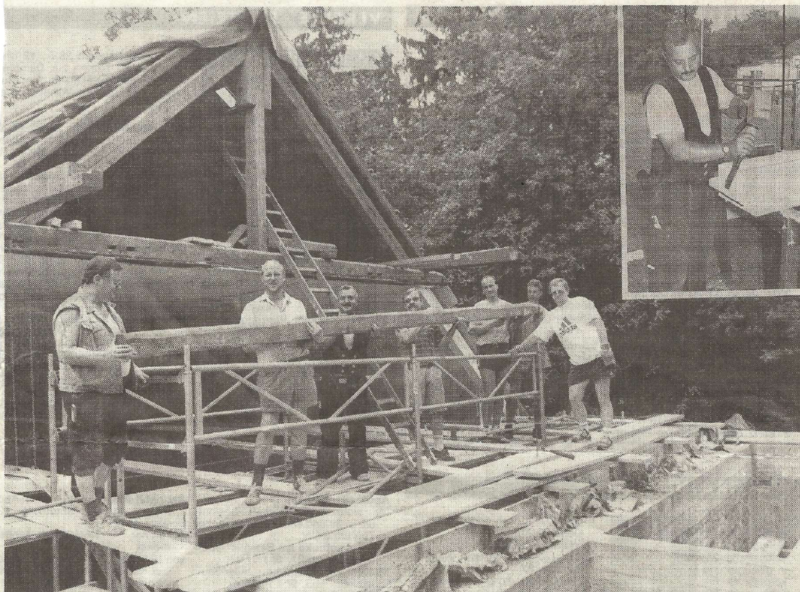
Die Vereinsmitglieder legen selbst Hand an bei der Erweiterung der Turnhalle des TSV Guntershausen. Die Arbeiten am Dachstuhl obliegen Zimmermann Alex Ajrab (kleines Bild). (Fotos: Fischer)
